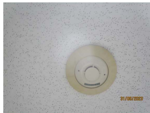
รูปที่ 52 Smoke/ Heat Detector
