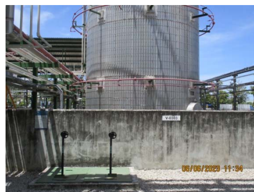
รูปที่ 34 คั่นคอนกรีตรอบถังเก็บ Isododecane
