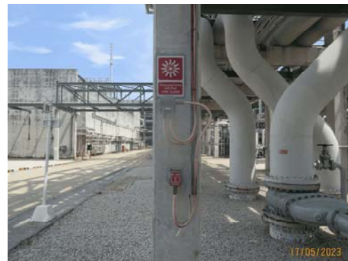
รูปที่ 50 Manual Pull Station
