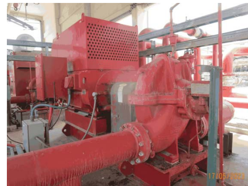
รูปที่ 58 Electric Fire Pump
