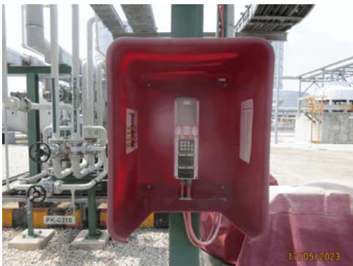
รูปที่ 63 อุปกรณ์แจ้งเหตุฉุกเฉิน
