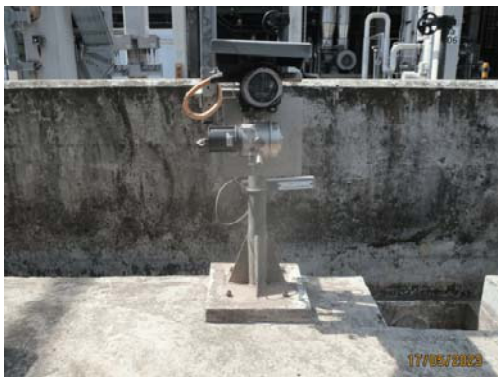
รูปที่ 49 Gas Detector
