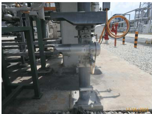
รูปที่ 51 Flame Detector
