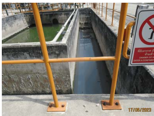
รูปที่ 9 Oil Separator
