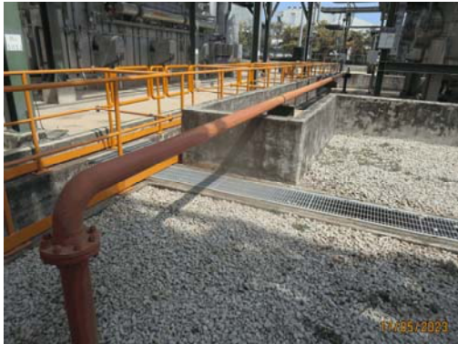
รูปที่ 65 ระบบผ่านน้ำดับเพลิงบริเวณหน่วย RTO
