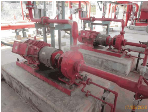
รูปที่ 59 Electric Jockey Pump
