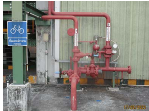
รูปที่ 42 Wet Alarm System
