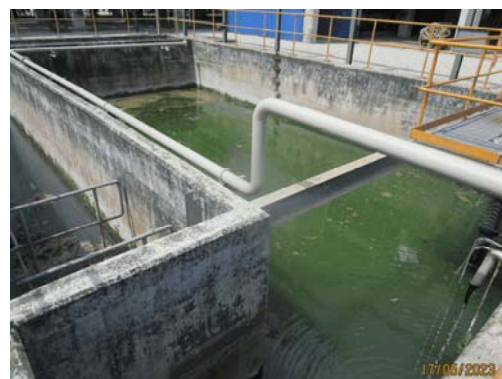
รูปที่ 12 บ่อพักน้ำทิ้งขนาด 260 ลูกบาศก์เมตร
